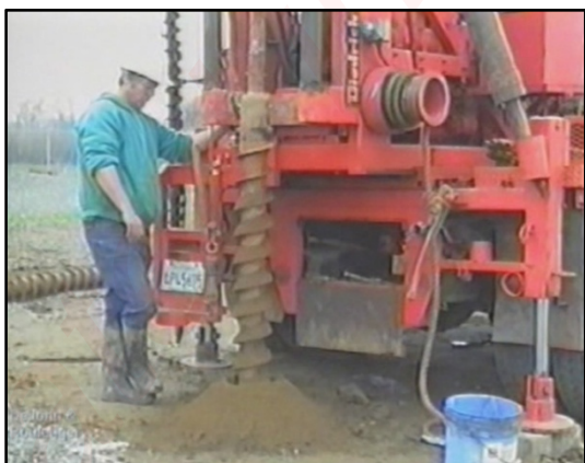
(ت) حفاری با منته های حلزونی حین اجرا
