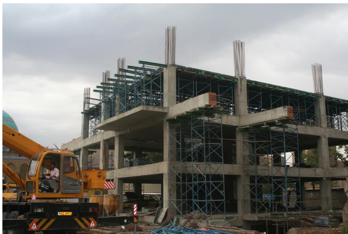
شکل (۷-۲۲): ساختمان نمایندگان مجلس در حال احداث
