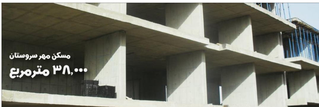
شکل (۷-۲۰): مسکن مهر سروستان در حال احداث
