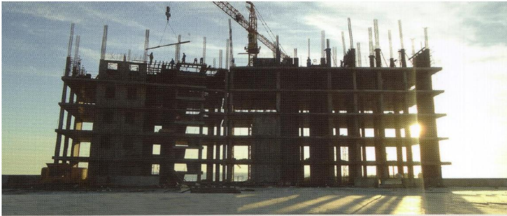
هتل و آپارتمان سپین سنتر قشم محل پروژه: جزیره قشم بلندترین دهانه: ۷/۵ متر ضخامت دال: ۲۲ سانتی متر زیربنا: ۱۰۰۰۰۰ متر مربع
