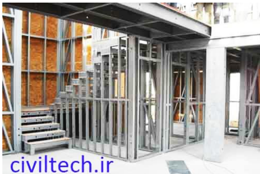
شکل (۴-۲۲): اجرای پله در سیستم قاب فولادی سبک
