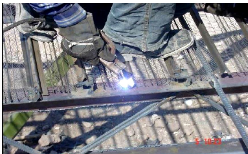
شکل (۱۲-۱۲): خال جوش کردن روفیکس روی تیرها
