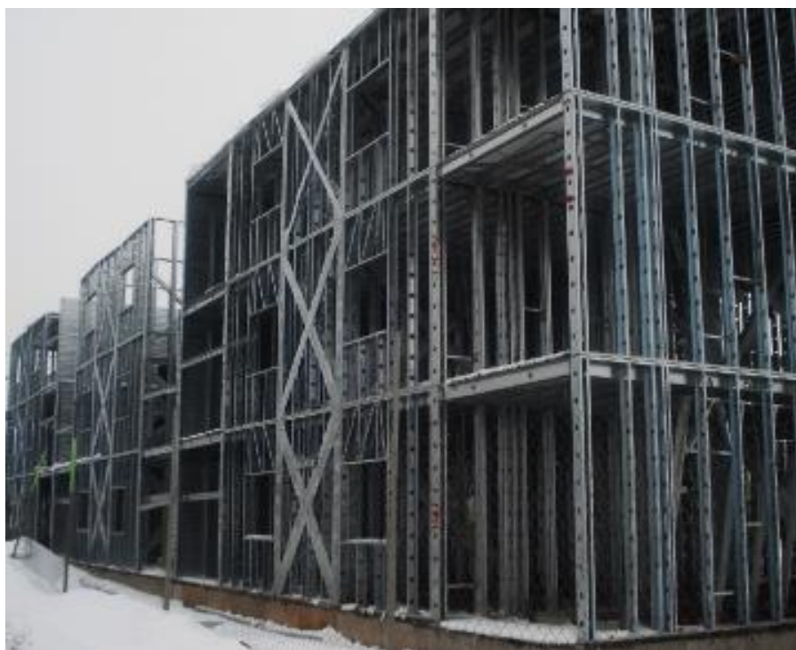
شکل (۴-۲۸): دهانه مهاربندی شده با مهاربند ضربدری
