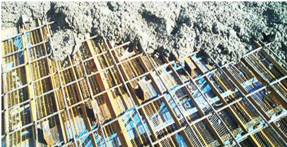
شکل (۱۲-۶): بتن‌ریزی سقف روفیکس
