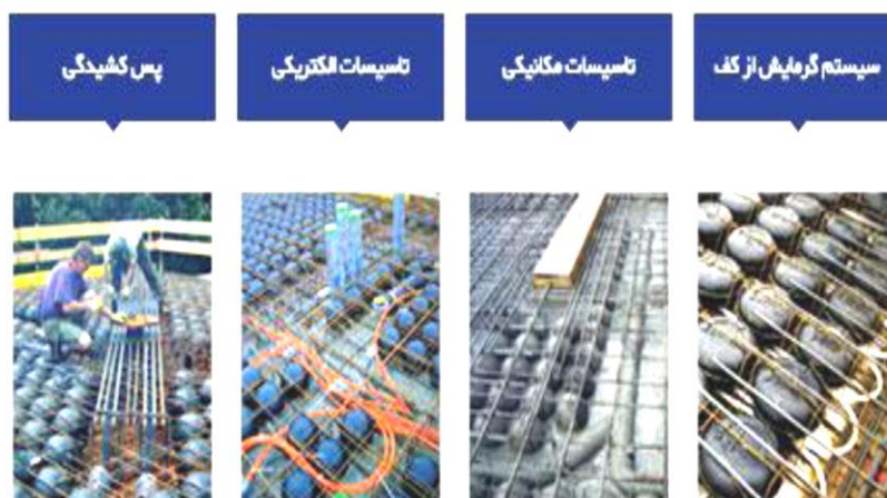
شکل (۸-۲): نحوه‌ی اجرای تأسیسات مکانیکی و برقی
