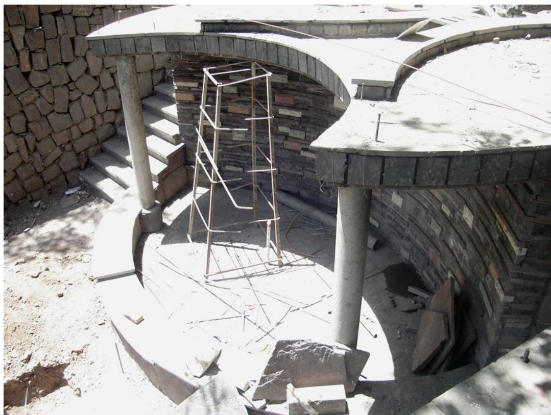
شکل (۷-۱۷): ساختمان یزدی نژاد در حال ساخت
