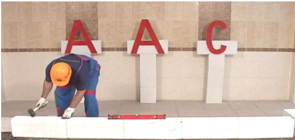
شکل (۱۳-۶): اجرای رج اول دیوار چینی با بلوک هبلکس
