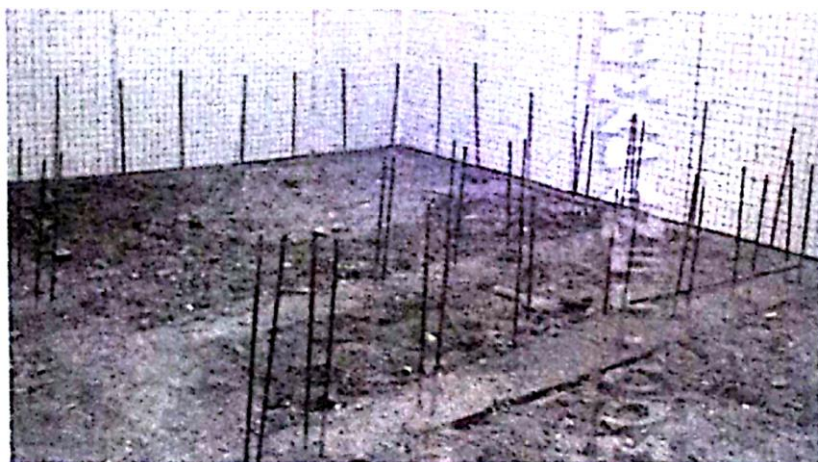
شکل (۶-۷): میلگردهای انتظار در پی
