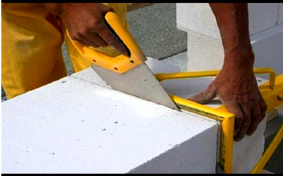
شکل (۷-۱۳): اجرای رج‌های بعدی دیوار چینی با بلوک هبلکس
