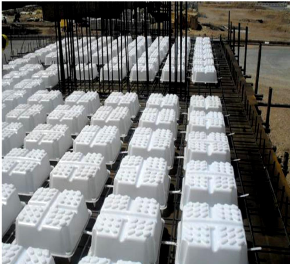
شکل (۶-۷): آرماتورگذاری سفره تحتانی در سقف یوبوت
