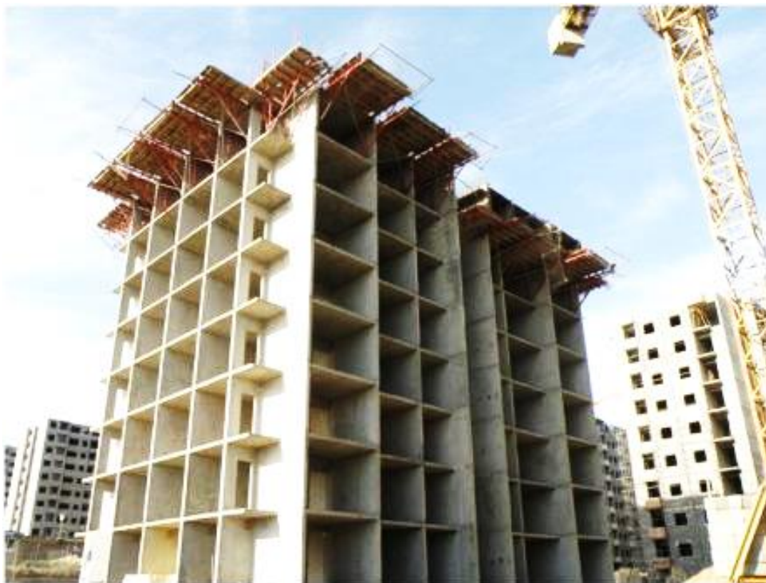
شکل (۷-۲): سیستم پانلی
