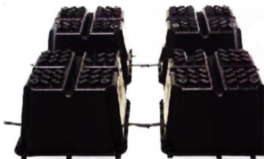
شکل (۳-۷): فاصله بین قالب‌های یوبوت
