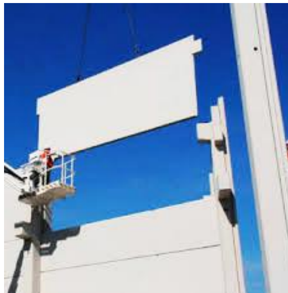
شکل (۵-۵): دیوار برشی بتنی پیش ساخته
