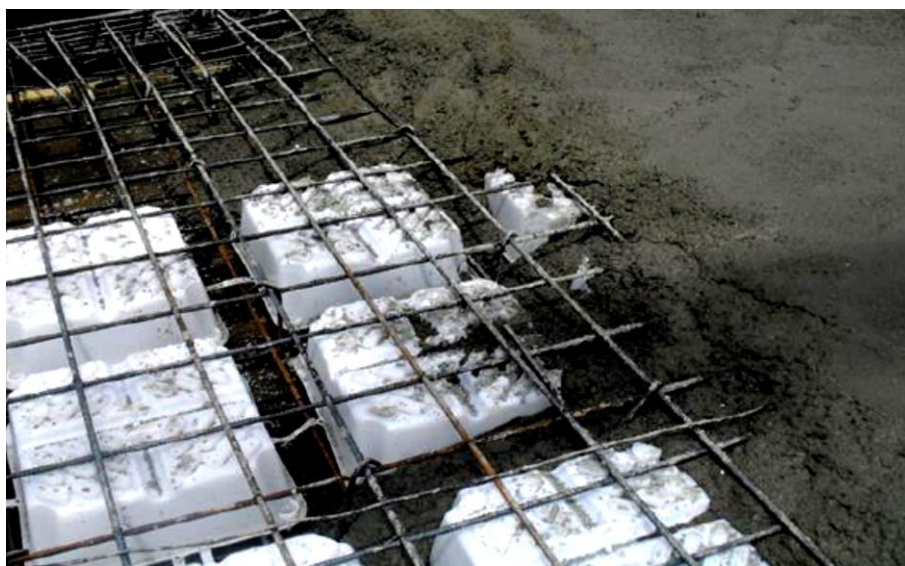
شکل (۷-۱۰): بتن‌ریزی تکمیلی در سقف یوبوت
