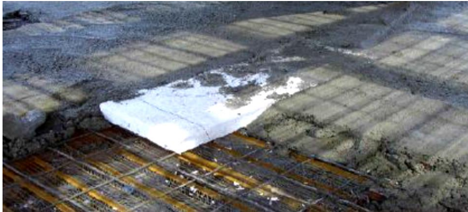
شکل (۱۲-۱۵): جلوگیری از ورود بتن به نواحی باز شو
