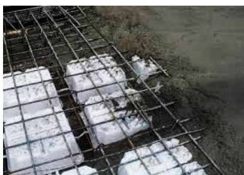
شکل (۴-۷): بتن‌ریزی سقف یوبوت
