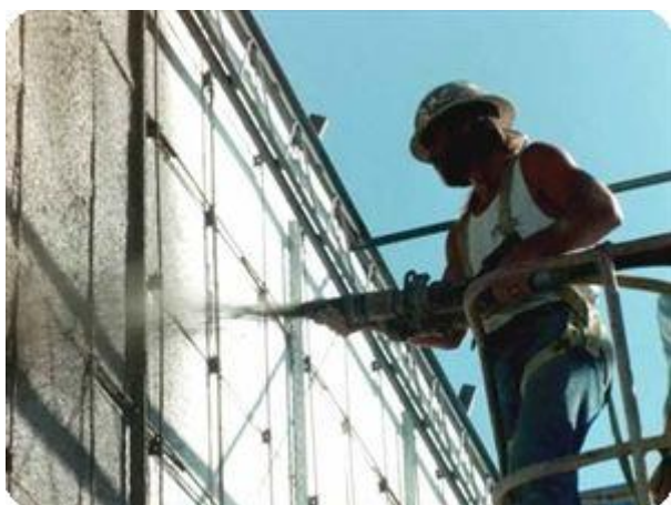
شکل (۶-۱۲): پوشاندن دو طرف پانل سه بعدی با بتن
