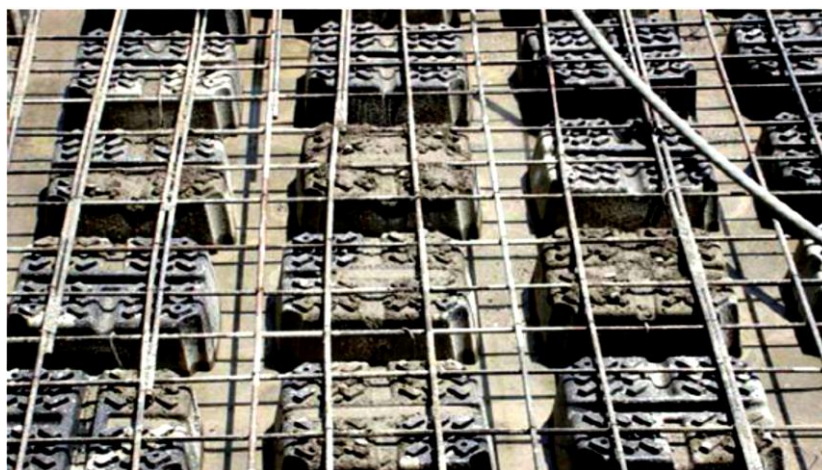
شکل (۷-۹): بتن‌ریزی لایه اول در سقف یوبوت
