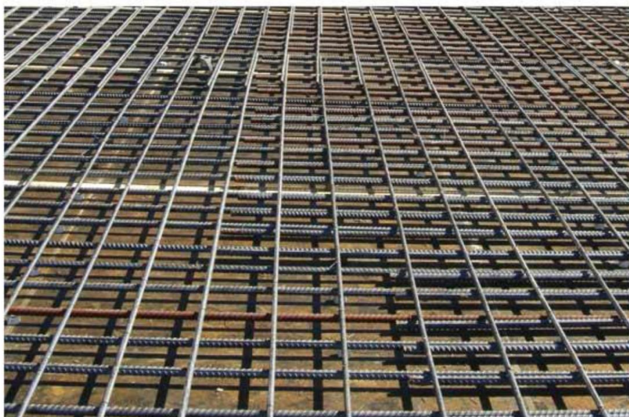
پ- قرارگیری توپ‌ها بر روی مش‌بندی تحتانی
