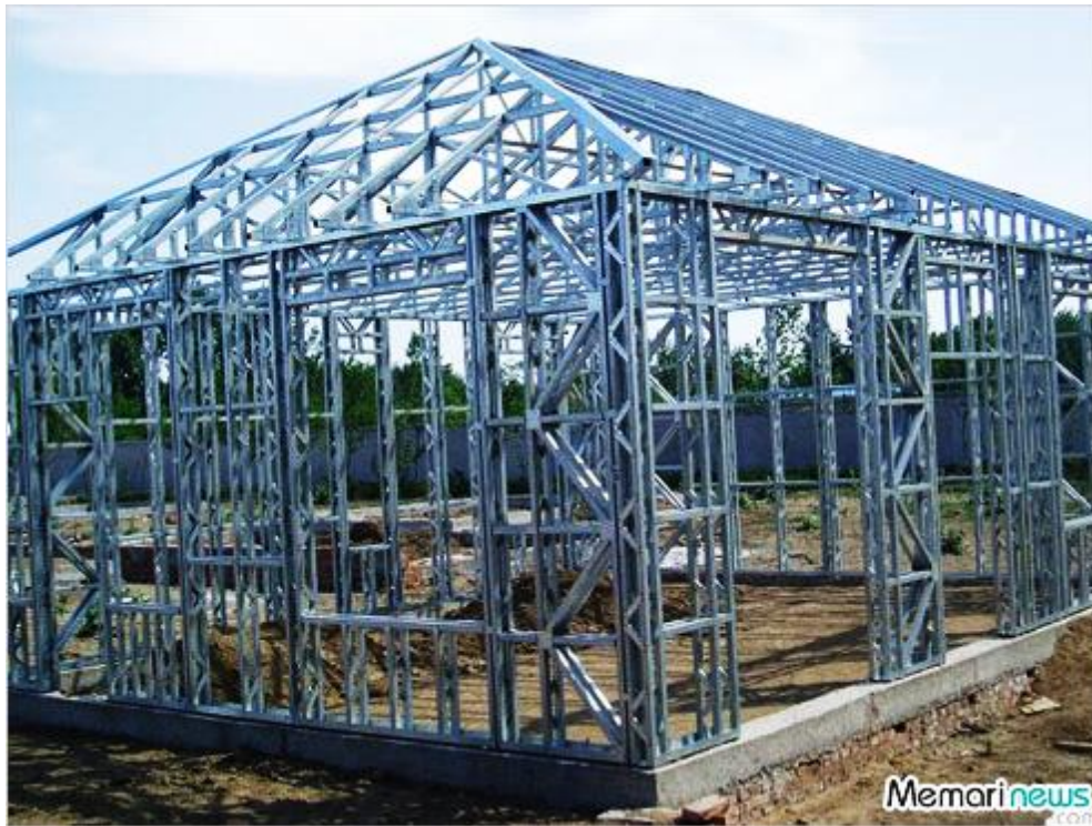
شکل (۴-۱): اعضای سازه‌ای سیستم قاب فولادی سبک نورد سرد
