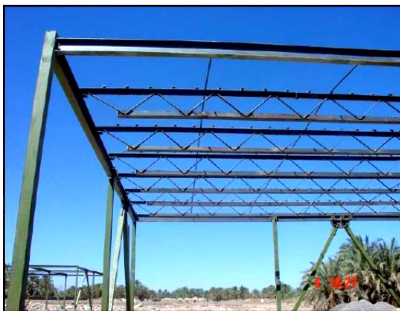
شکل (۱۲-۴): نصب سریع تیرهای دلتا
