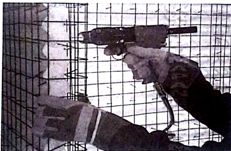
شکل (۶-۸): نصب پانل‌های دیوار و اتصالات
