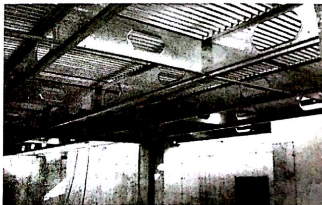
شکل (۴-۱۹): اجرای سقف در سیستم قاب فولادی سبک نورد سرد
