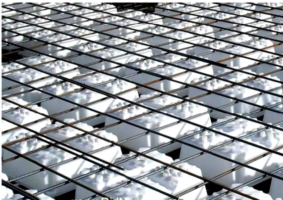
شکل (۷-۸): آرماتورگذاری سفره فوقانی در سقف یوبوت
