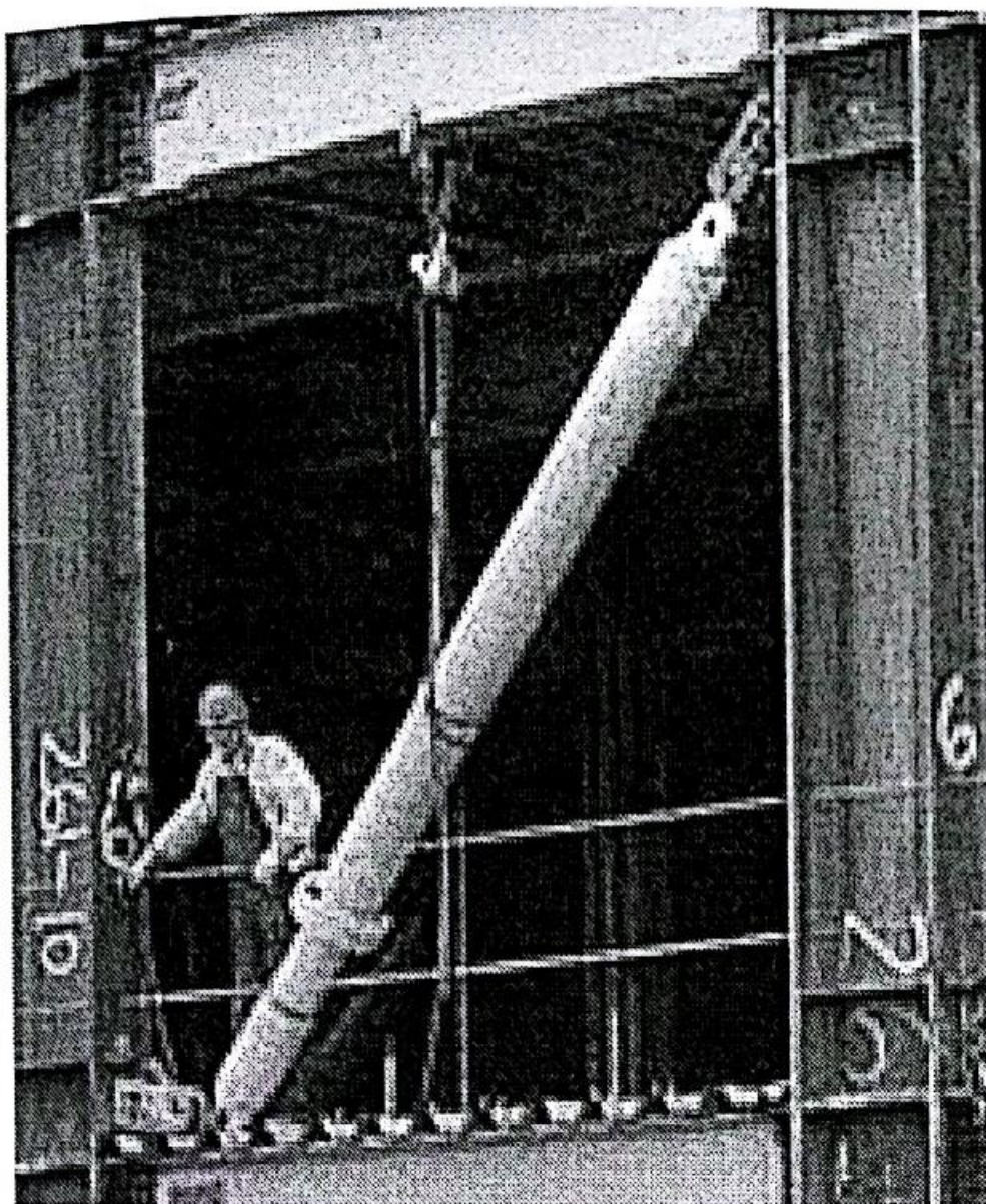
شکل (۹-۱۱): تعبیه میراگر ویسکوز مایع در ساختمان
