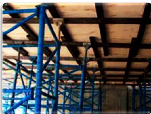
شکل (۷-۵): قالب‌بندی سطح زیرین دال
