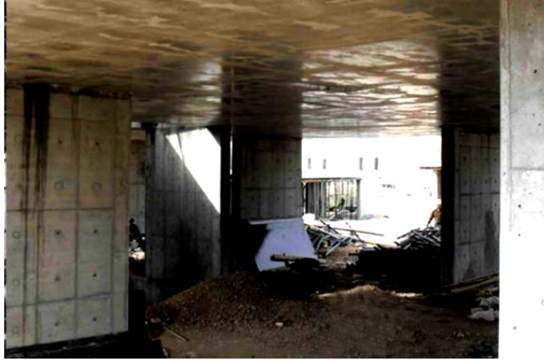
شکل (۷-۱۱): باز کردن قالب‌های کف
