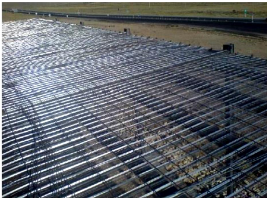
شکل (۱۳-۱۲): تعبیه شبکه آرماتور
